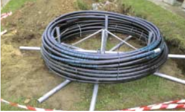
Eine einfache Vorrichtung erleichtert das Abwickeln der flexiblen FLEXWELL-LPG Rohrleitung vor Ort.
